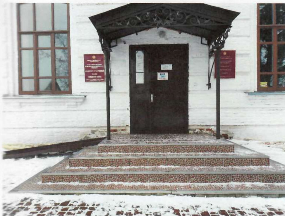
Фото 2. Вход (входы) в здание
