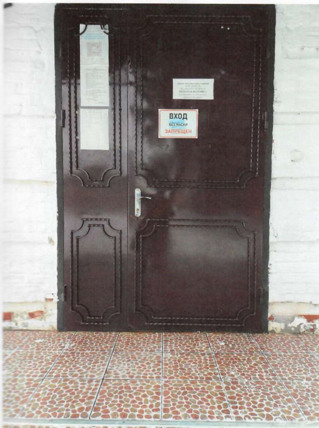
Фото 4. Вход (входы) в здание
