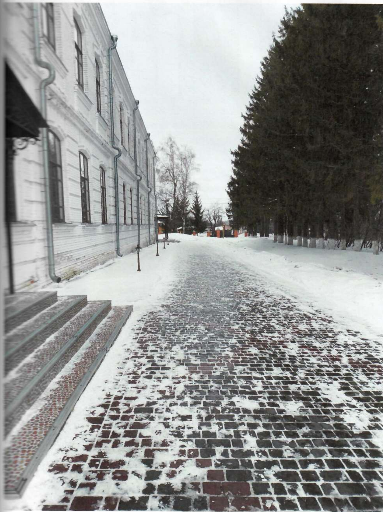
Фото 1. Территория, прилегающая к зданию (участок)
