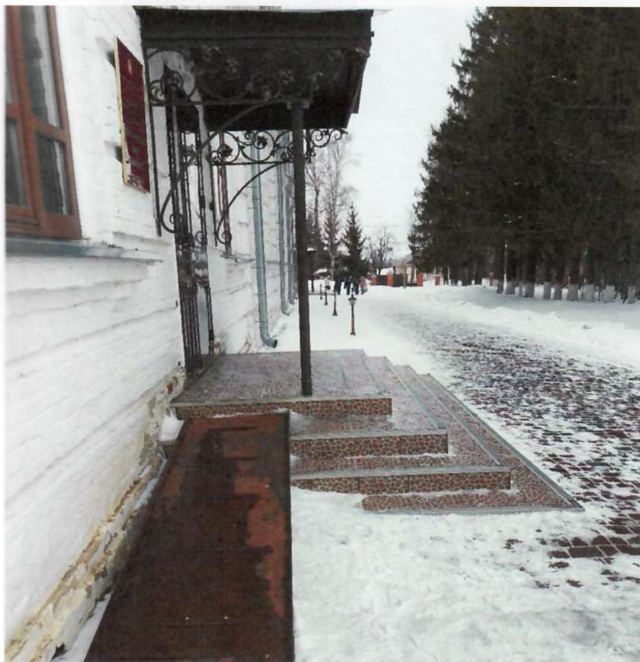
Фото 3. Вход (входы) в здание
